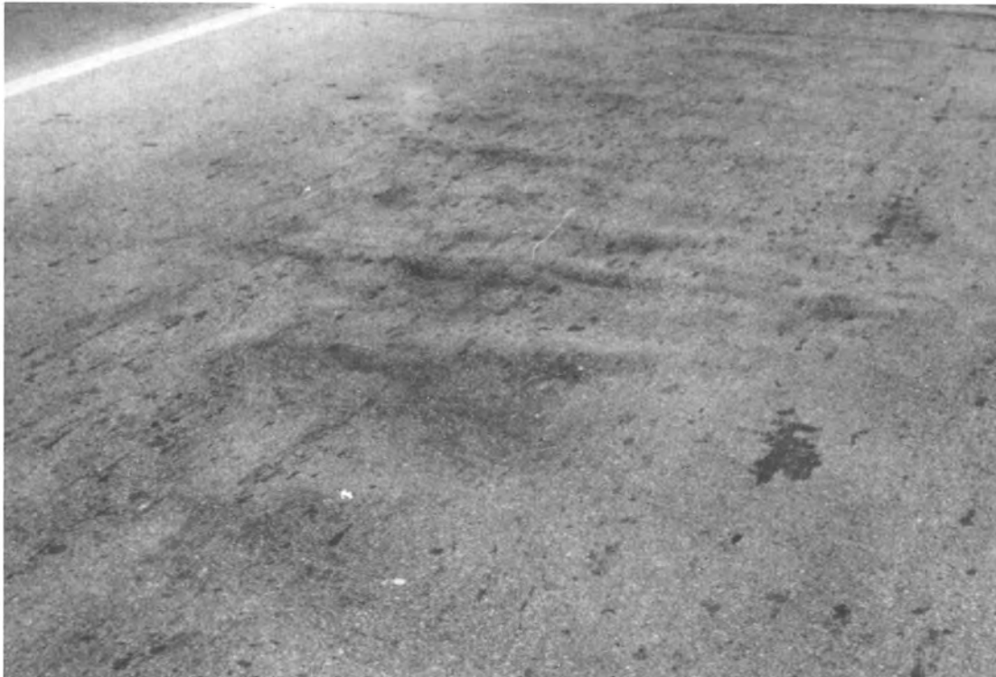
Severe Rippling
